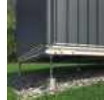
Höhenausgleich mit Erdschrauben
