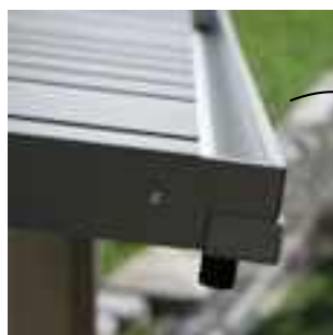
Integrierte Regenrinne an der Vorderseite.
